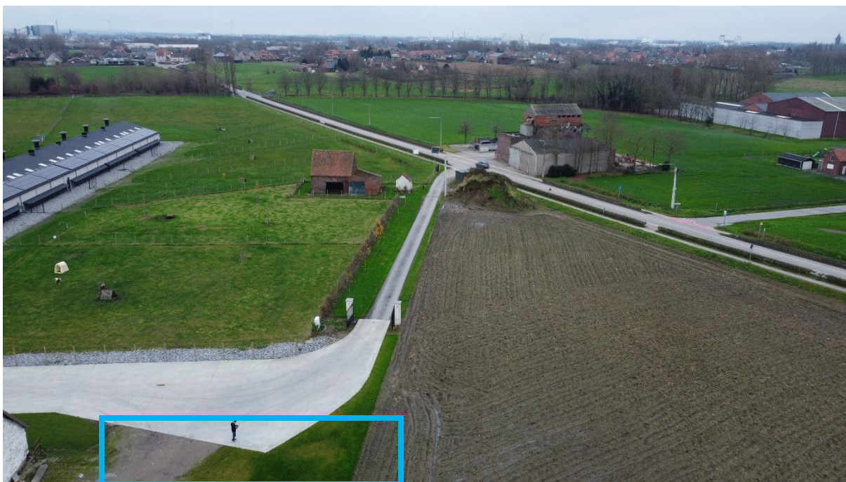
Uitbreiding betonverharding te regulariseren
