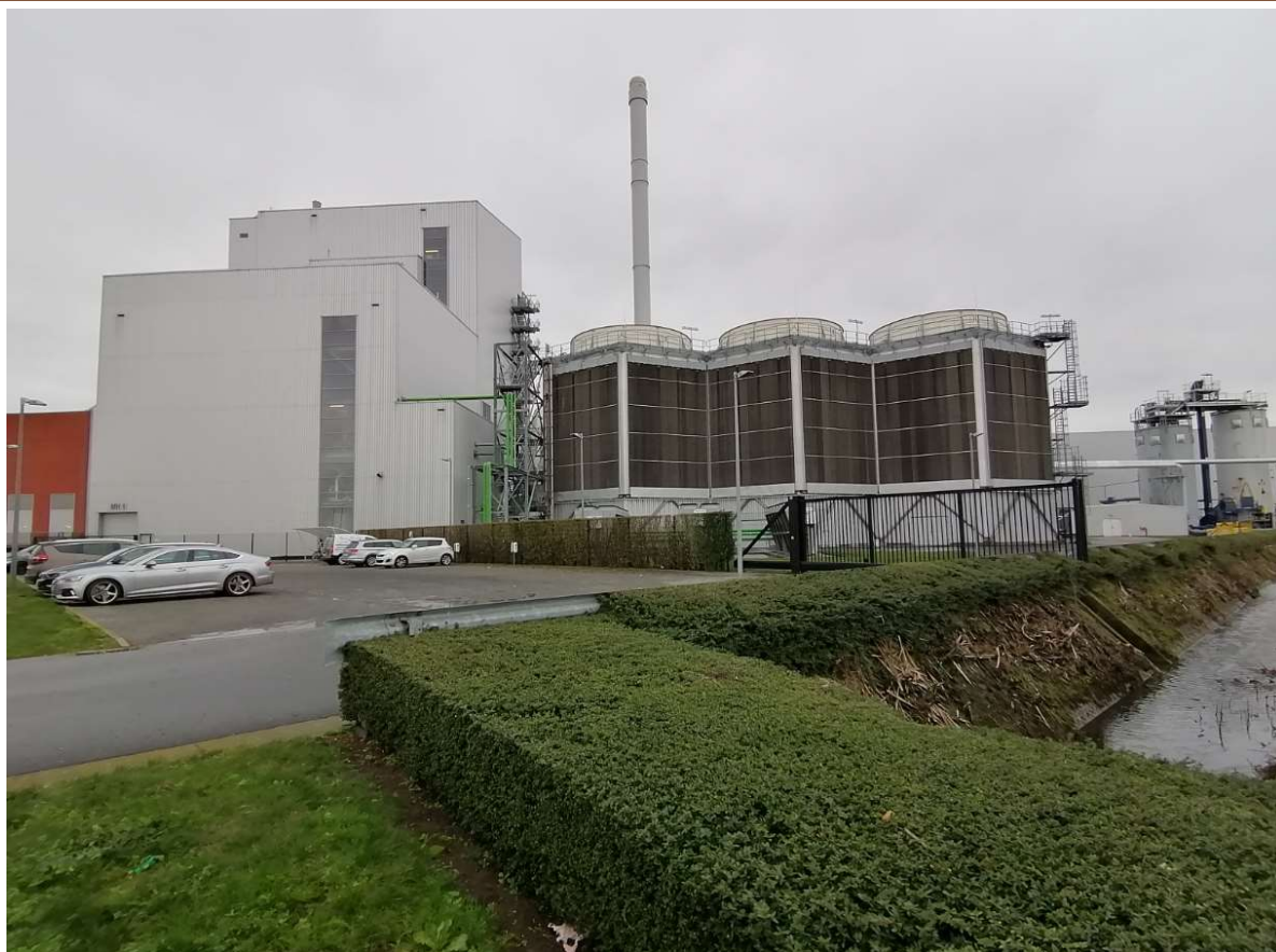
Foto 2 vanuit Oostelijke richting
