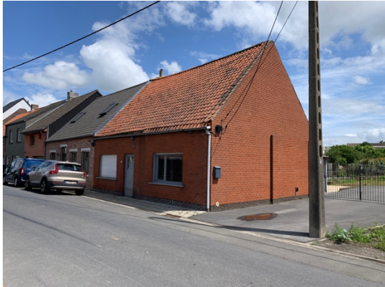
Foto's van de bestaande toestand
