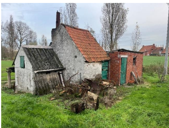
Authentieke ovenbuur (5a en 5b) Gebouw in rode baksteen (5c) en afdak (5d) te slopen
