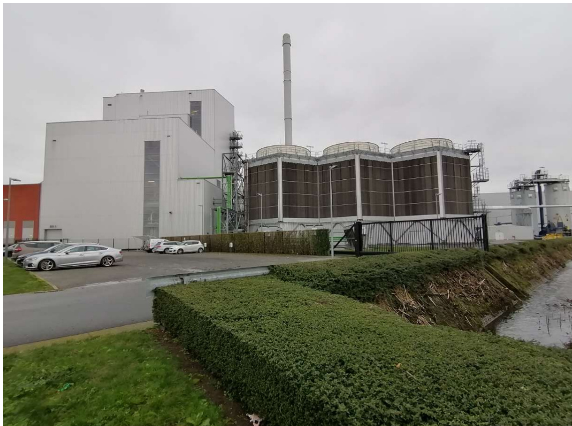
Foto 2 vanuit Oostelijke richting
