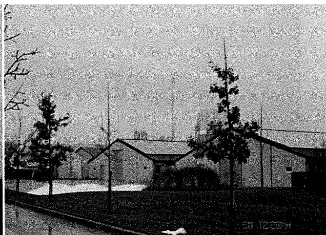
Zicht op biocrachtinstallatie vanuit MP 1
