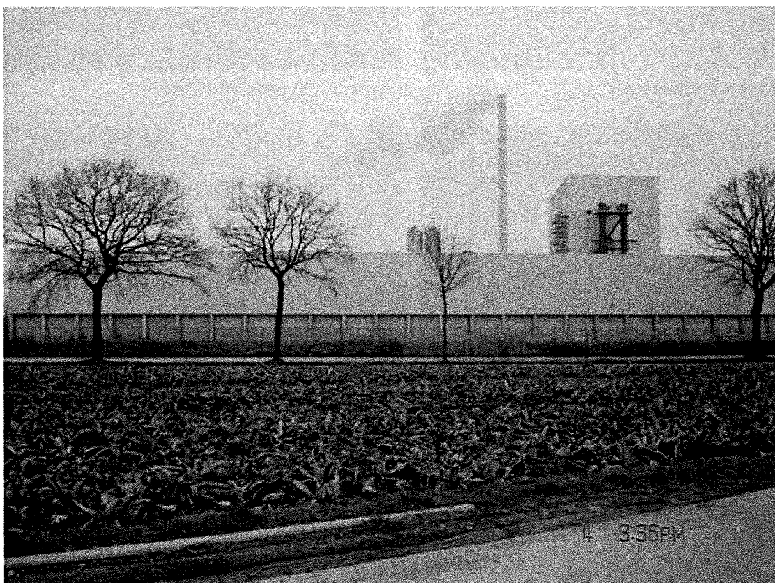
Overzichtsfoto met de biocrachtinstallatie van A & S energie, getrokken vanuit omgeving MP 1
