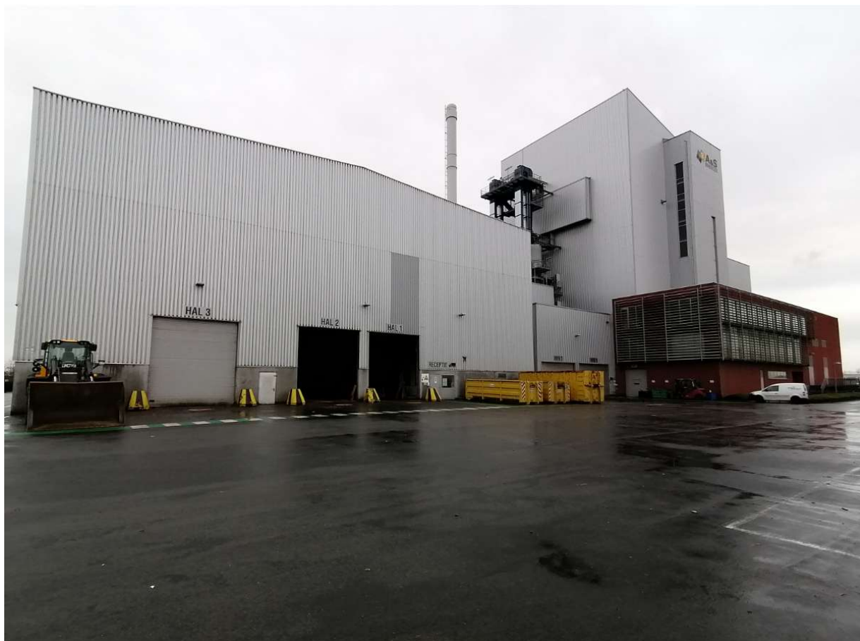
Foto 3 vanuit Zuidelijke richting
