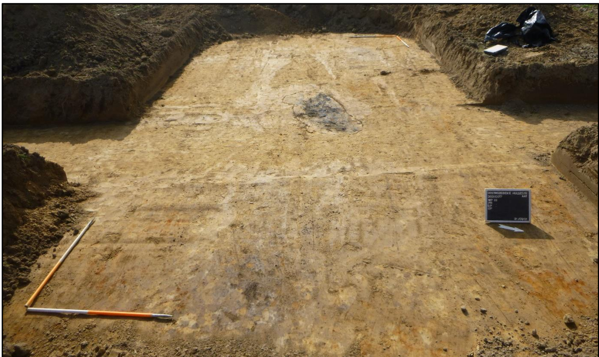
Figuur 26: Algemeen zicht op kijkvenster bij werkput 18 vanuit het oosten (ABO nv 2021)
