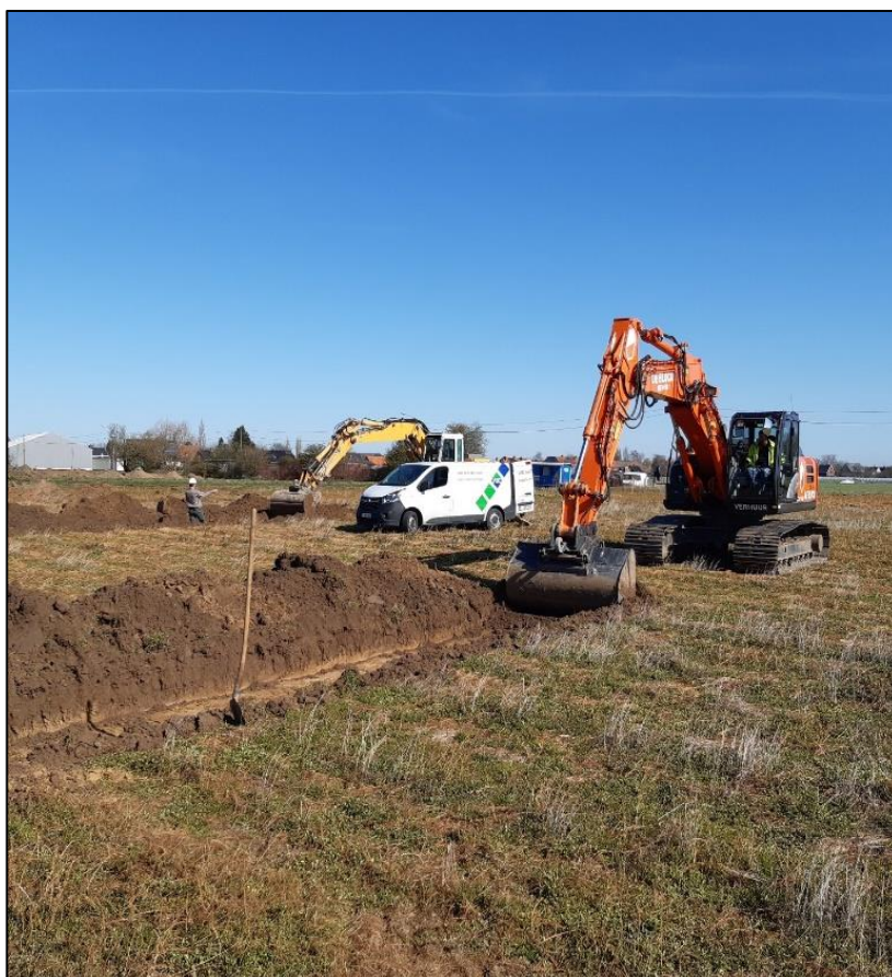
Figuur 8: Uitvoering van sleuven (ABO nv 2021)
