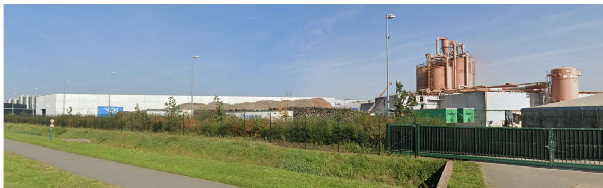
Figuur 15: Zicht vanaf de Expressweg op de zone waarin de nieuwe hal 3 wordt gebouwd (links de lichtgrijze hal 11, rechts de bestaande hal 3)
