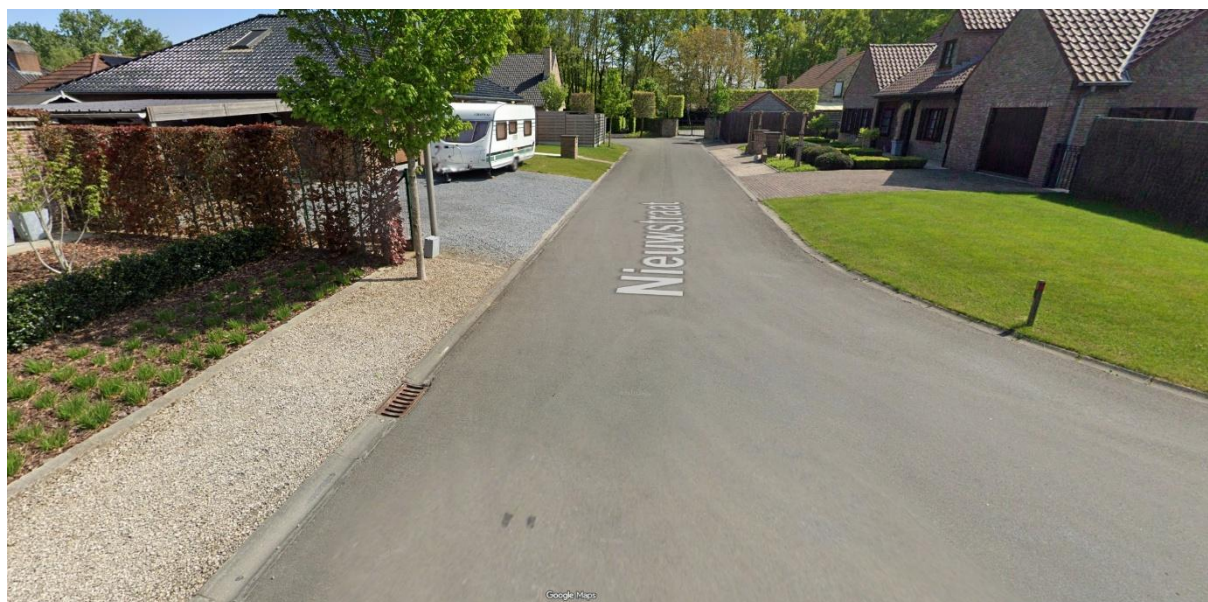
Figuur 6: Foto bestaande toestand Nieuwstraat (bron: opdrachtgever)
